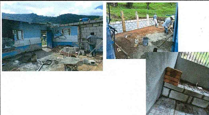
Foto 3: Inicio de los trabajos de mejoramiento de la cocina y polletones
