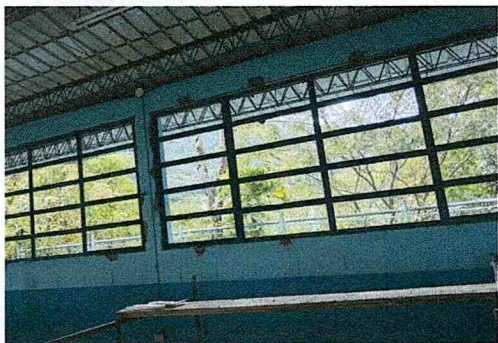
Foto1: Inicio de retiro para el mejoramiento de las ventanas
