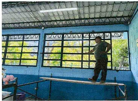
Foto 2: Avance en el retiro y colocación de ventanas
